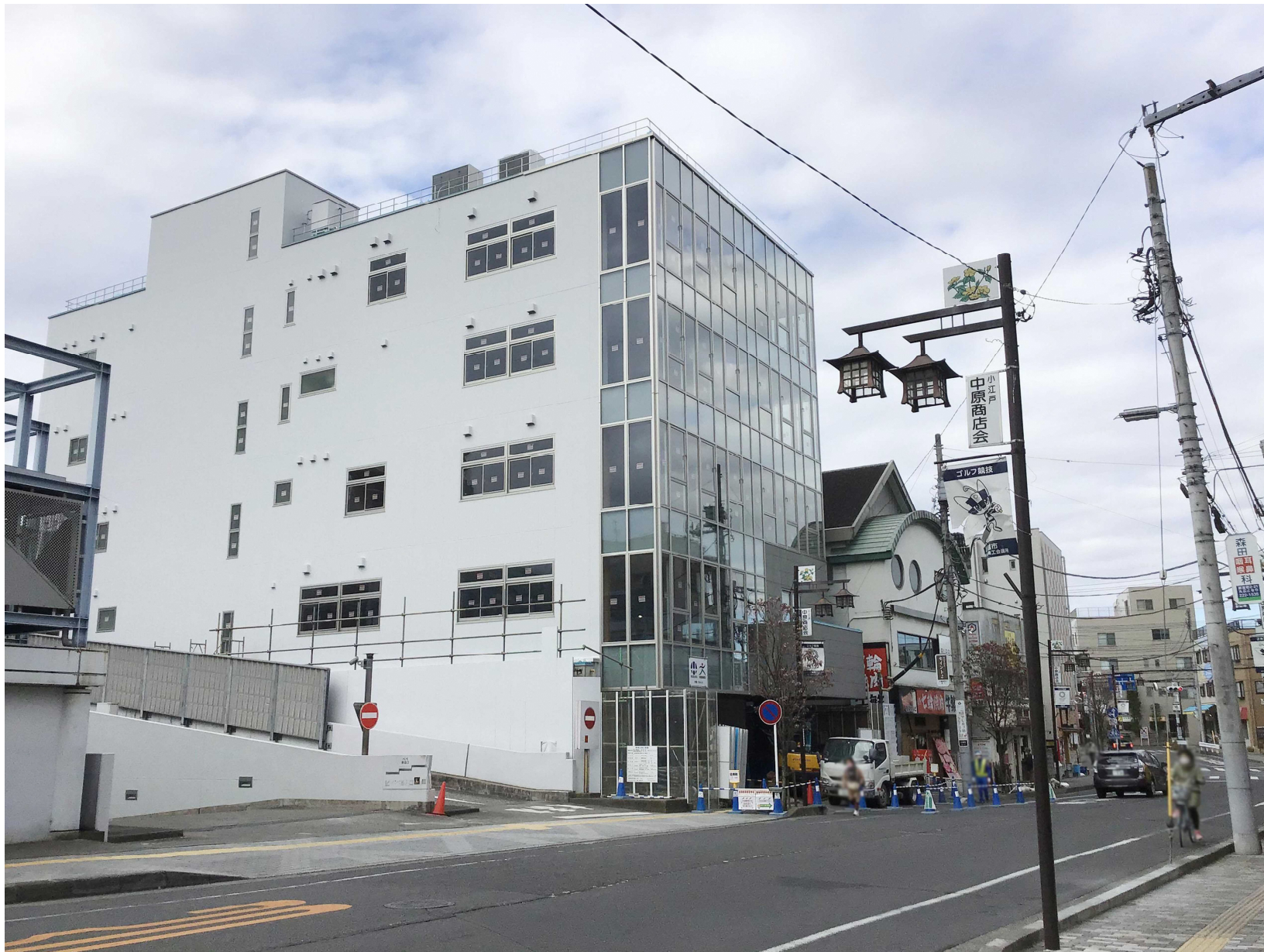
【屋外防水工事完了】 (令和2年11月24日撮影)
