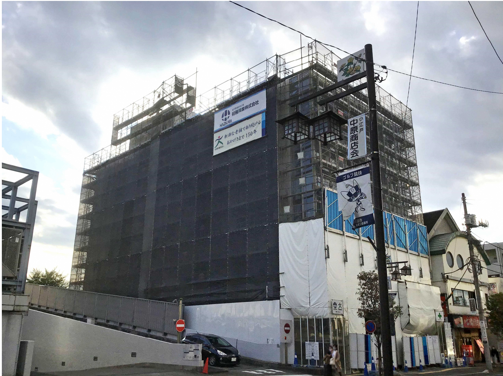
【外装工事完了】 (令和2年10月24日撮影)
