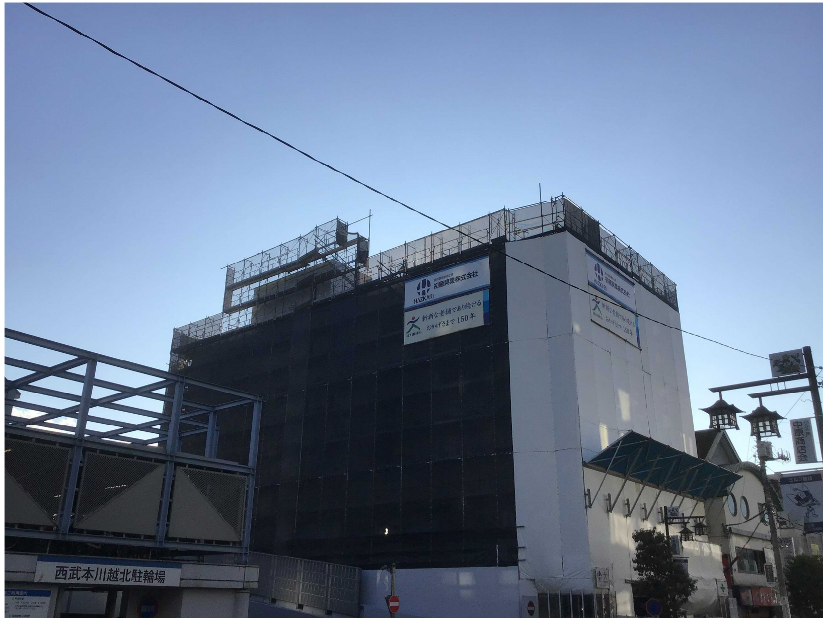
【外壁（ALC）設置完了】（令和2年9月28日撮影）
