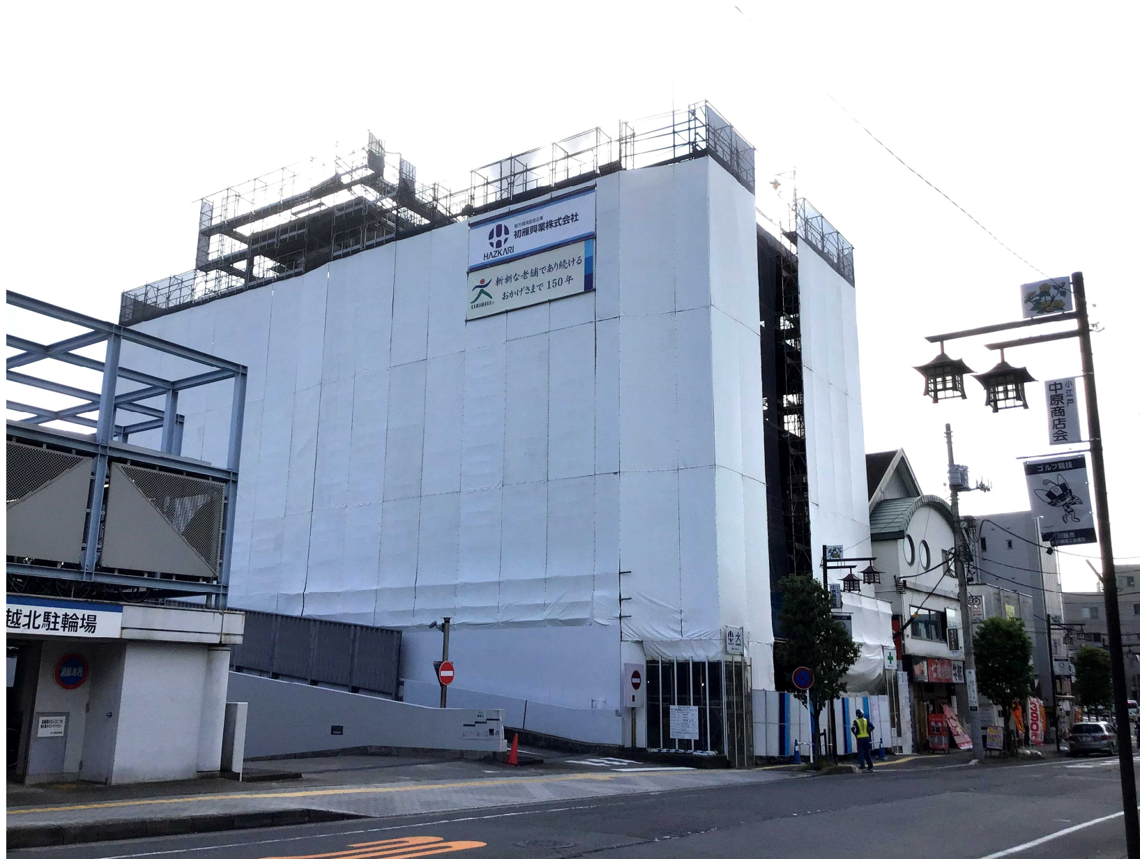
【スラブコンクリート打設完了】 (令和2年8月24日撮影)
