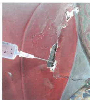
■構造補強作業
