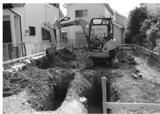
トレンチ掘削状況
