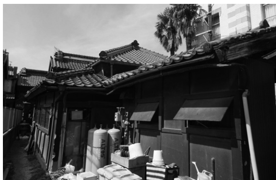
修理前（損傷箇所）
