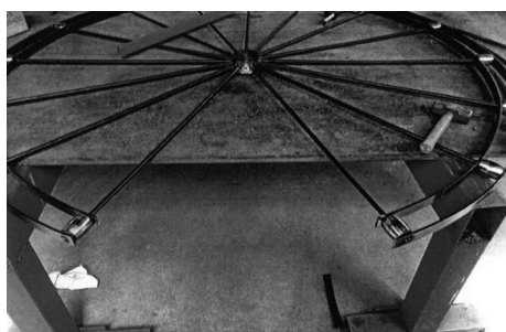
工変形部分の切断
