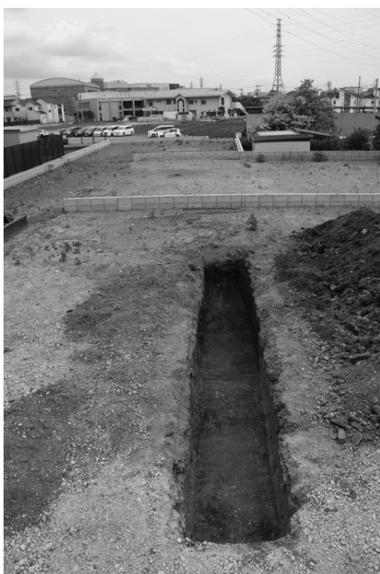
トレンチの掘削状況（北西から）
