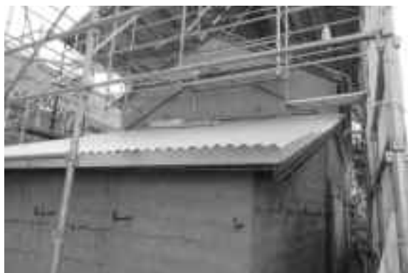
第2期工事完了後
