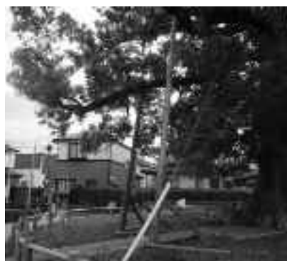
丸太支柱設置
