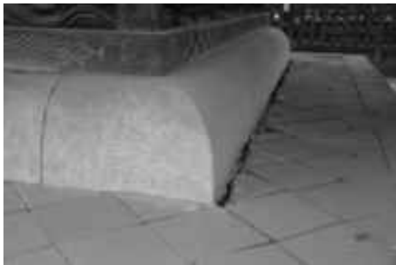
背面亀腹と敷石に生じた亀裂・隙間（左：東から 右：西から）
