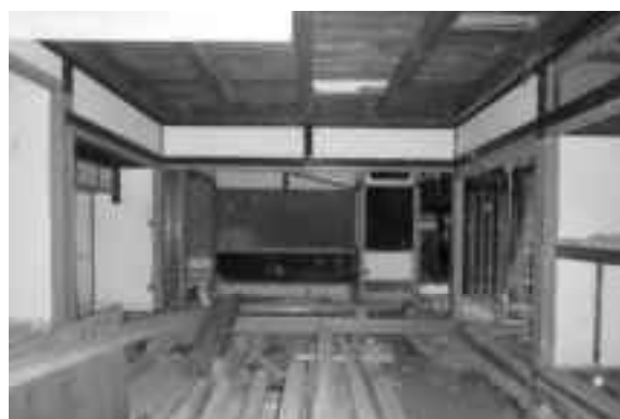
住居棟 現況（1階）
