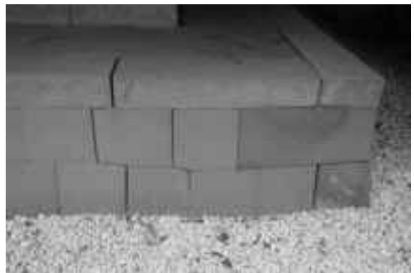
東側面北東隅付近の基壇石積のずれ（左：北東から 右：東から）
