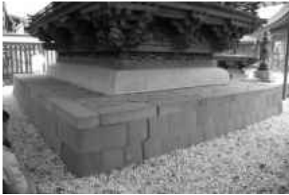
西側面北西隅付近の基壇石積のずれ（左：北西から 右：西から）
