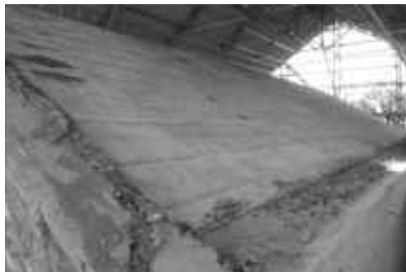
第1期工事完了後
