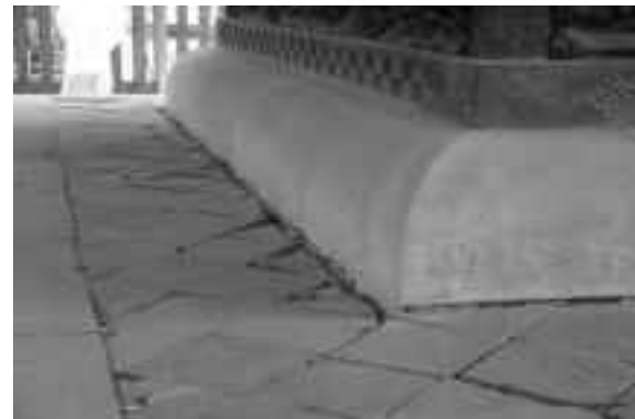
背面亀腹と敷石に生じた亀裂・隙間（左：東から 右：西から）
