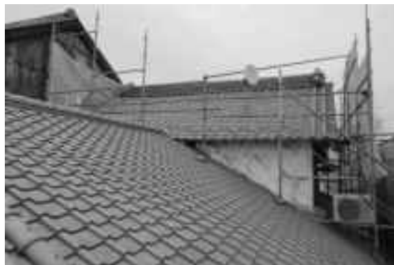
第1期工事完了後
