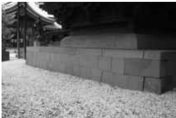
東側面北東隅付近の基壇石積のずれ（左：北東から 右：東から）
