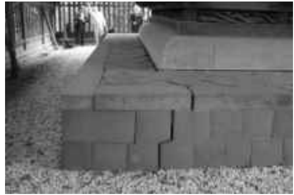
西側面北西隅付近の基壇石積のずれ（左：北西から 右：西から）
