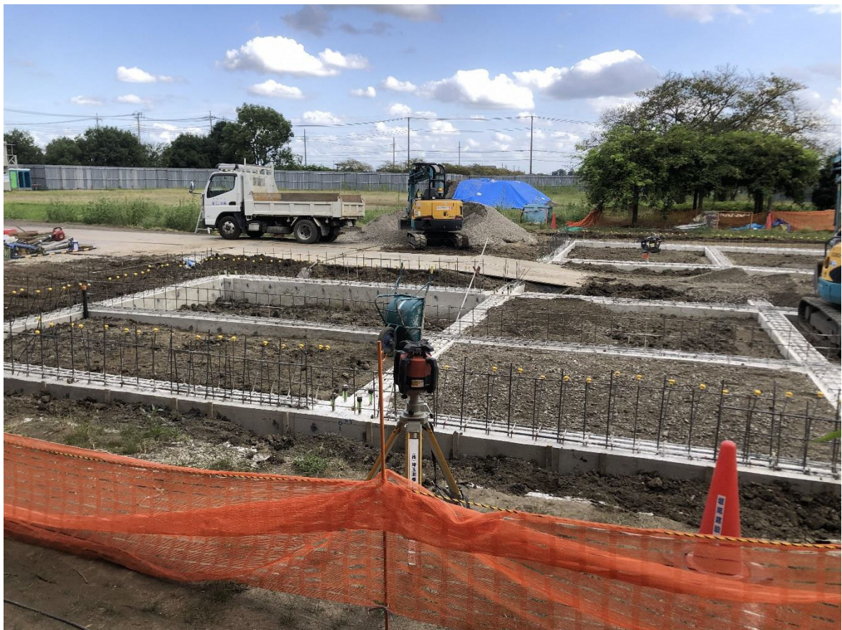
バーベキュー施設の基礎工事を行っています。
