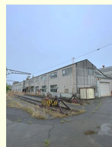
川越作業所外観
