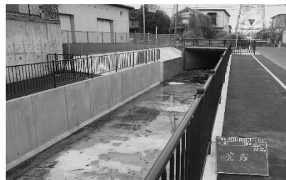
改修後の久保川の写真
