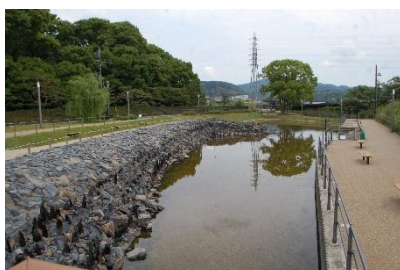
再現された石積み護岸
