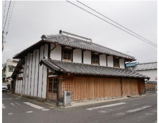
復旧した高久家住宅
