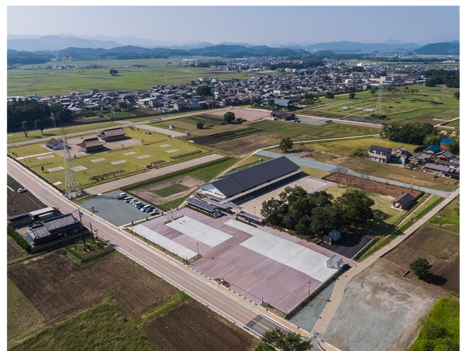
整備状況の全景
