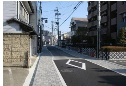
高質化を実施した街路
