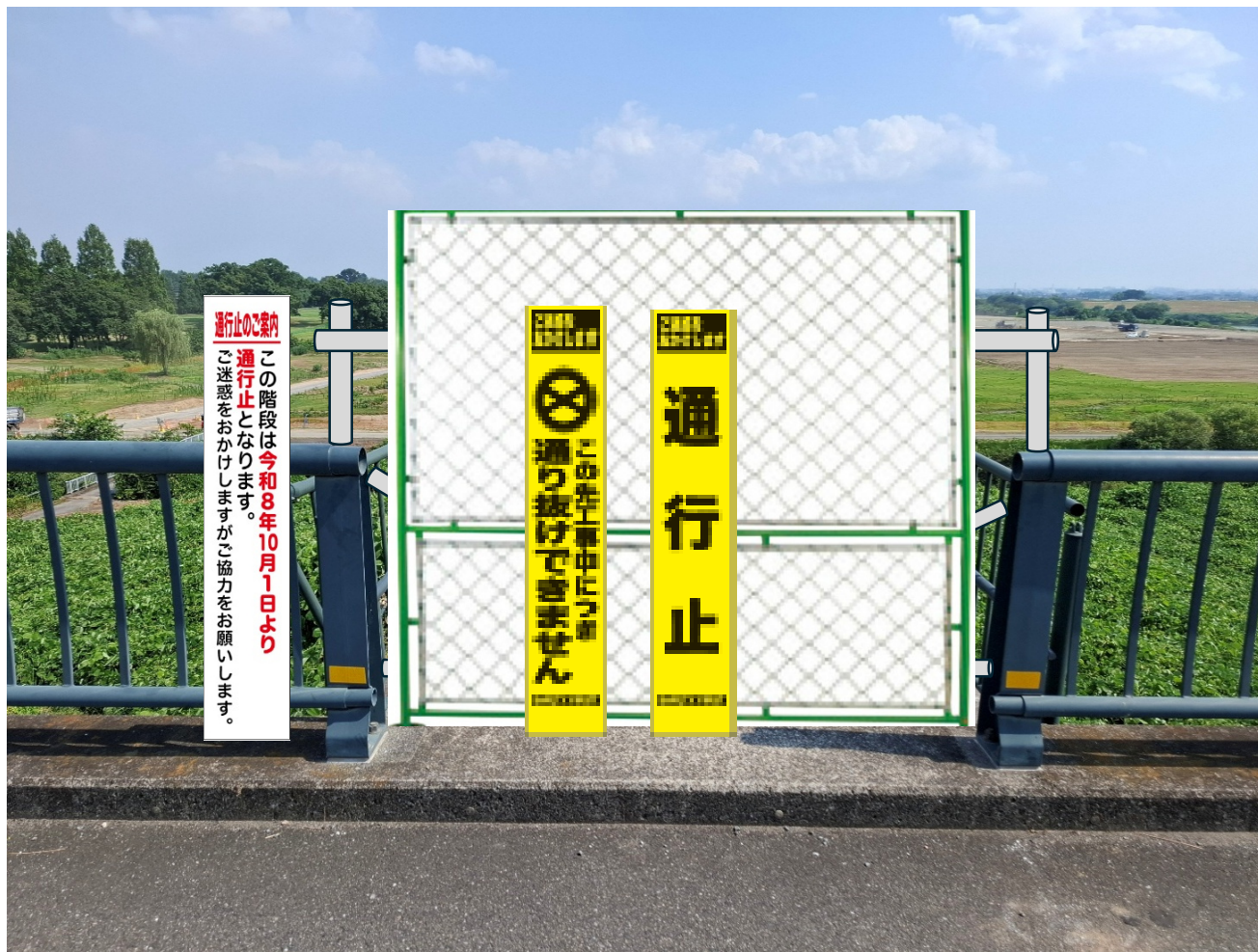
上江橋 立ち入り禁止柵設置 (階段上部)
