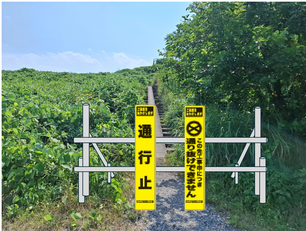
上江橋 立ち入り禁止柵設置 (階段下部)
