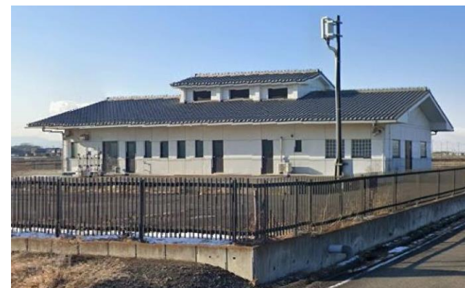
農業集落排水処理施設 ▲ (石田本郷処理区)
