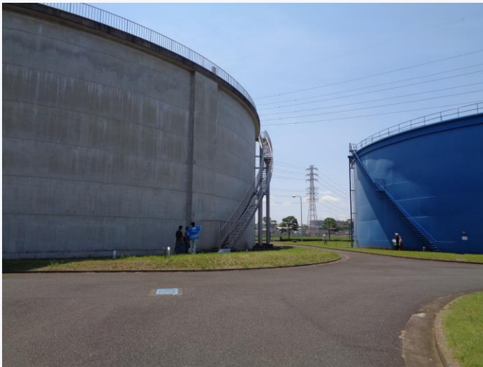
はいすいち 配水池(中福受水場)
