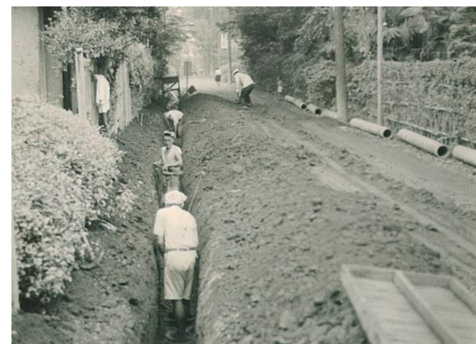
▲ 配水管布設工事の様子 (昭和39年)
