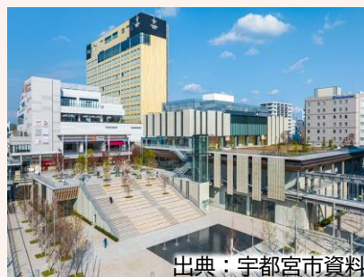
【事例】 宇都宮駅東口（栃木県宇都宮市）
