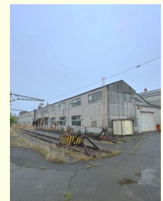
川越作業所外観
