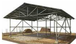
屋根と柱のみ
