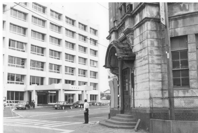
現庁舎と旧庁舎 ※昭和 47(1972)年
