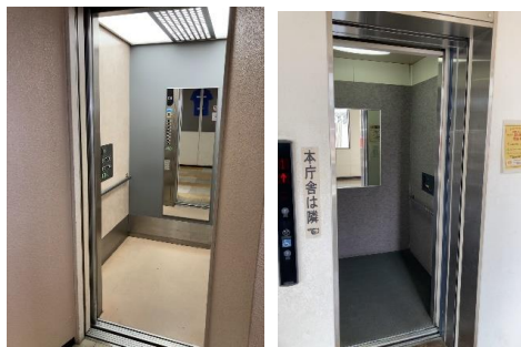
本庁舎・東庁舎エレベーターのかごの状況 ※左写真は本庁舎、右写真は東庁舎
