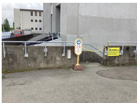
本庁舎通用口の地上出入口 ※東側より撮影
