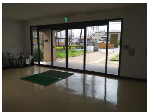
小仙波庁舎正面玄関 ※風除室未設置
