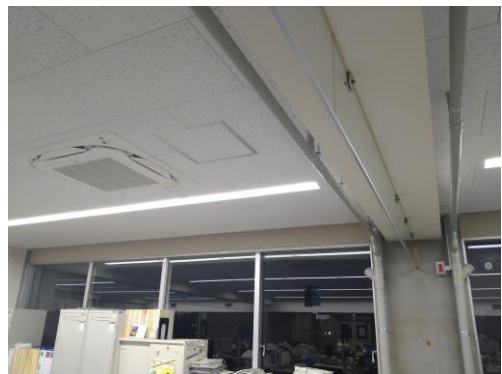
改修後の空調機器と配管(本庁舎 4 階) ※天井と柱に空調機器や配管を後付け
