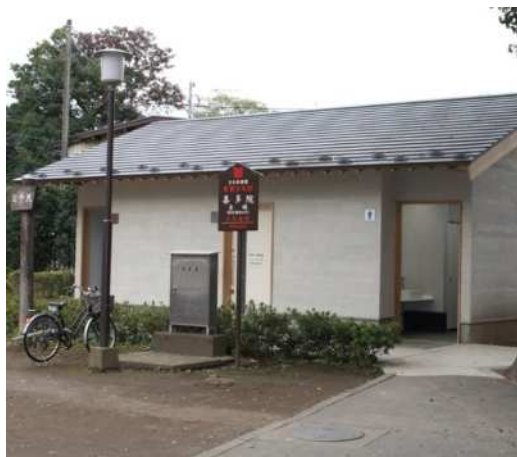
改築工事後の喜多院境内トイレ
