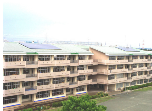
公共施設に設置した太陽光パネル (霞ヶ関北小学校)
