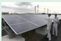
太陽光発電設備の検査の様子
