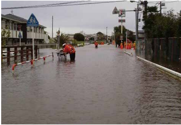
平成 29 年台風第 21 号による浸水 (寺尾地区)
