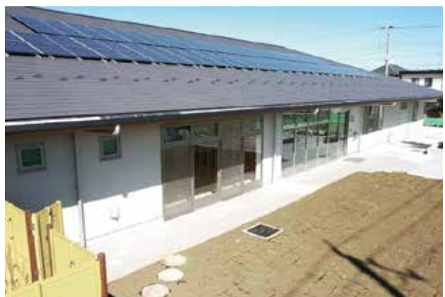
公共施設に設置した太陽光パネル （霞ヶ関北市民センター）
