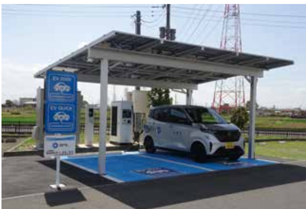
太陽光発電を活用した 電気自動車充電スポット（なぐわし公園）
