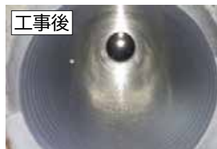
汚水管きょ更生工事
