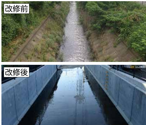
河川改修（久保川）
