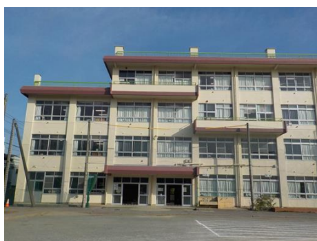
大規模改造工事を実施した学校
