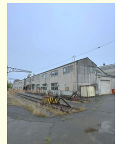
川越作業所外観
