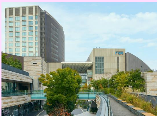
【事例】二子玉川ライズ（東京都世田谷区）
