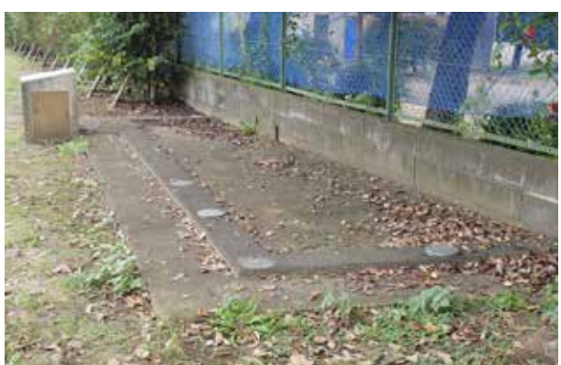
復元掘立柱建物の現状
