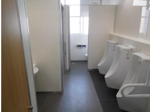
トイレ改修工事を実施した学校
