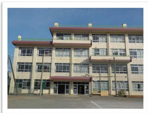
大規模改造工事を実施した学校
