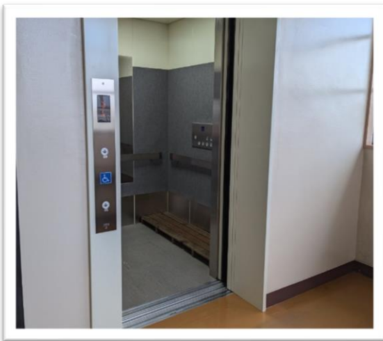
エレベーター改修工事を実施した学校
