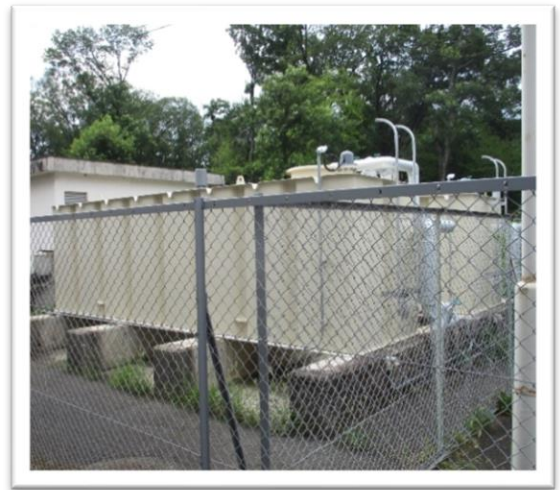
受水槽設備更新工事を実施した学校
