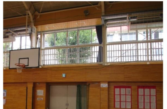
体育館空調設備設置工事を実施した学校
