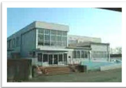
第一分室（リバーラ）外観
