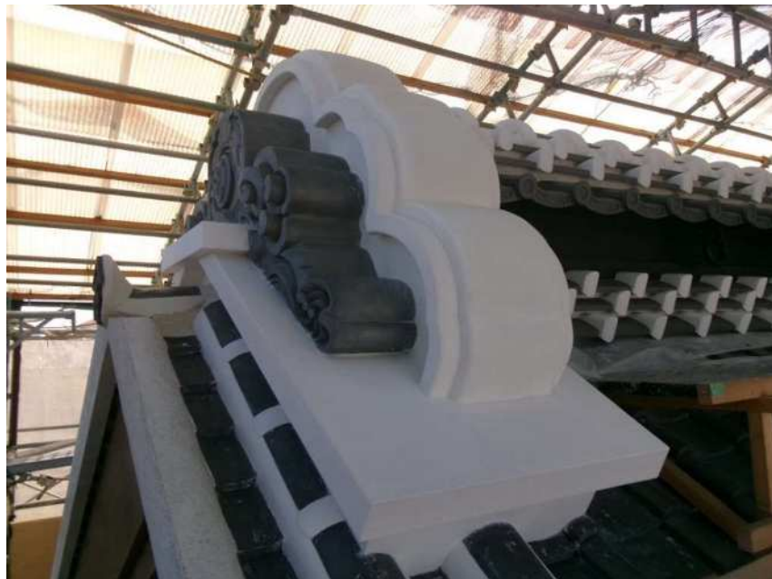
影盛上塗り(白漆喰)完了 箱棟大面部の仕上げ(黒漆喰)塗り
