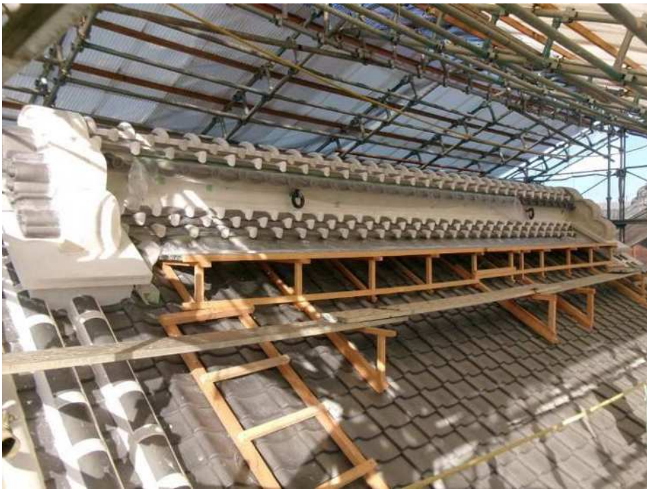
屋根周りの状況
