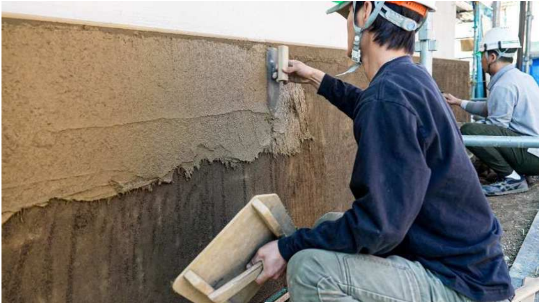
砂漆喰・大津縛りに続く腰巻中塗り
