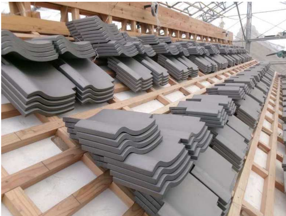
瓦棧に置かれたいぶし瓦 瓦葺き準備
