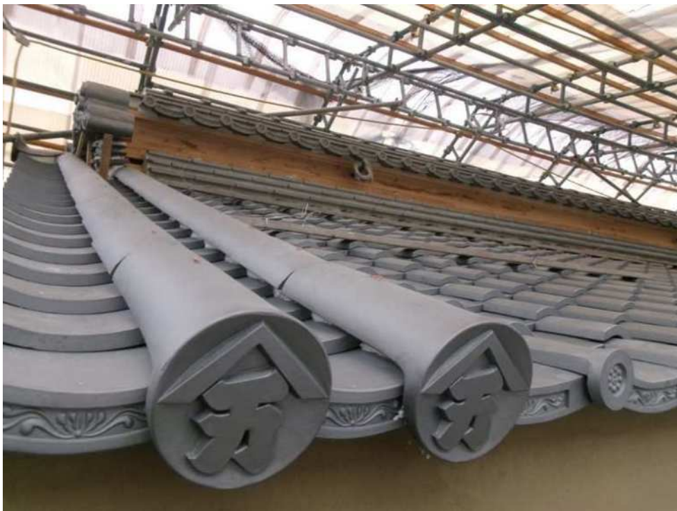
鬼瓦(鬼台下地)設置・箱棟屋根瓦(雁振・熨斗瓦・萱唐草)葺き
