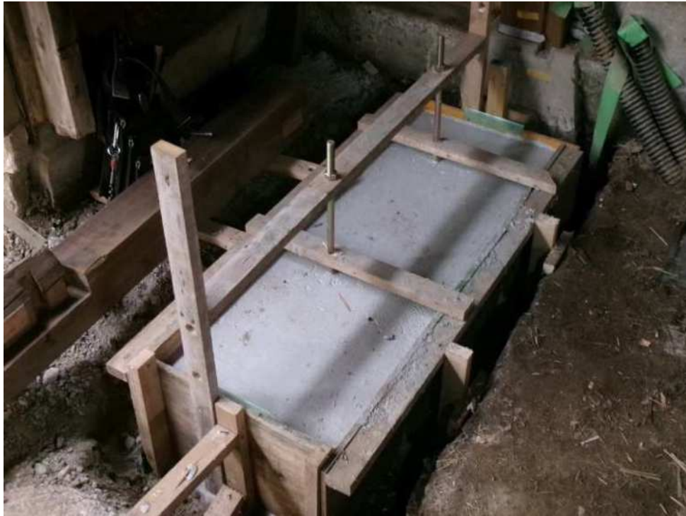
耐震補強壁基礎打設
