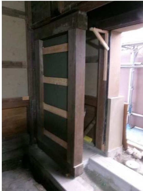
耐震補強壁木造フレームに塗られた荒壁
