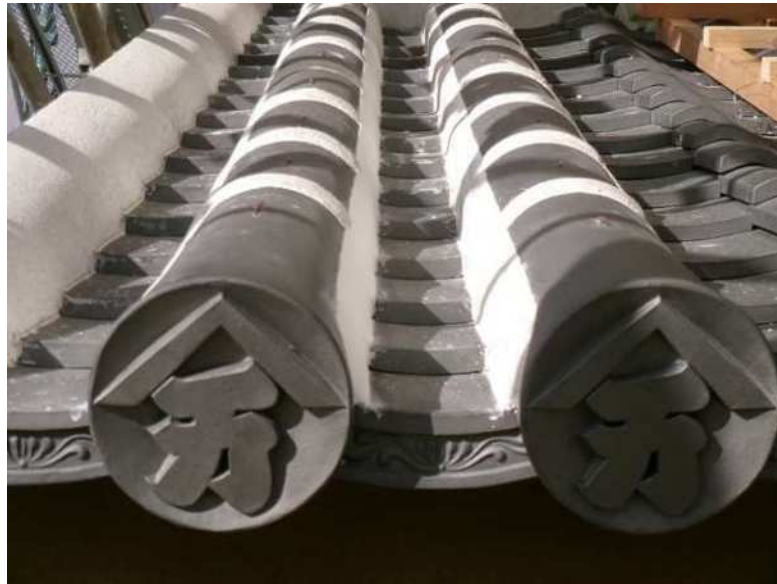
風切丸瓦に白漆喰塗りを施す（仕上げ）
