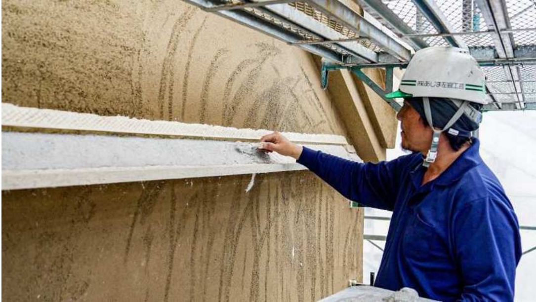
外壁に水切りを施す
