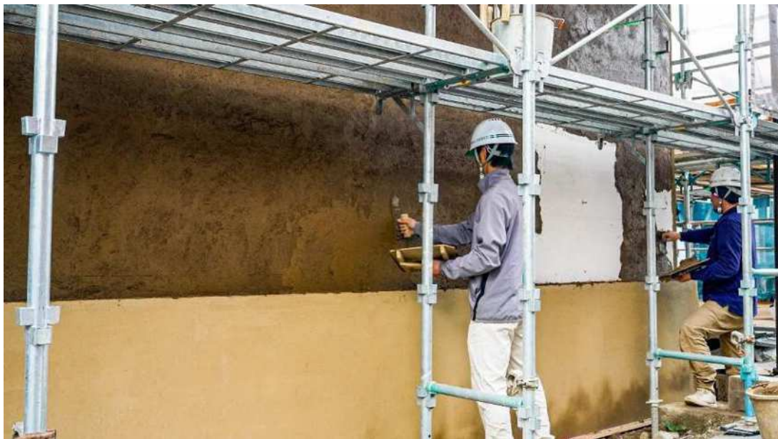
大津縛り後の斑直し(外壁)
