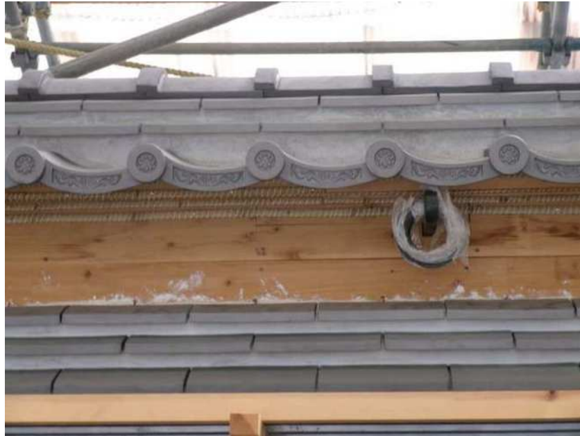
箱棟木下地の腹板に取り付けられた巻小舞
