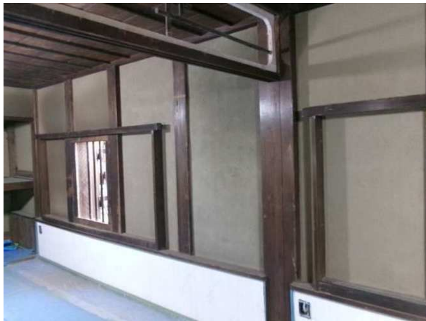
2階和室鼠漆喰壁中塗り
