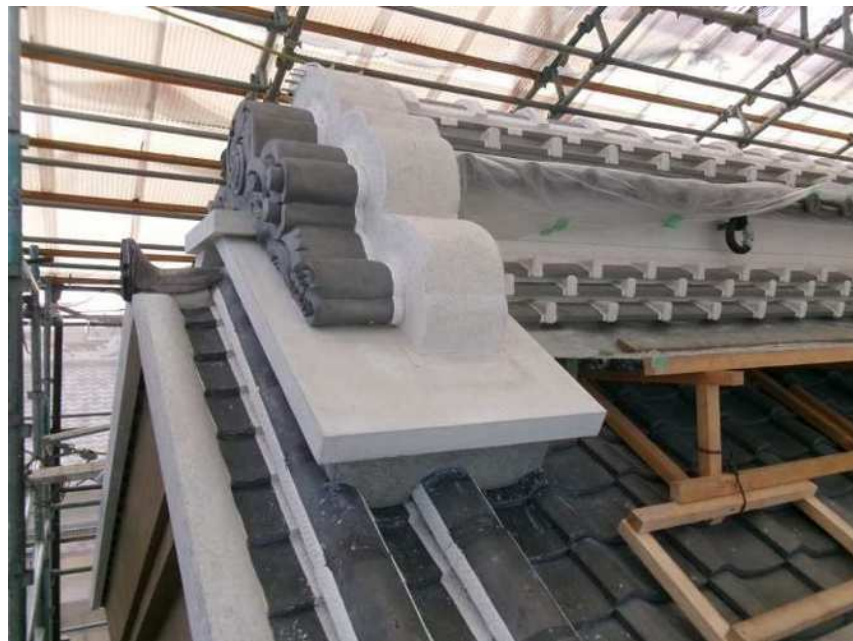
箱棟屋根漆喰中塗り 鬼台下塗り 影盛下塗り
