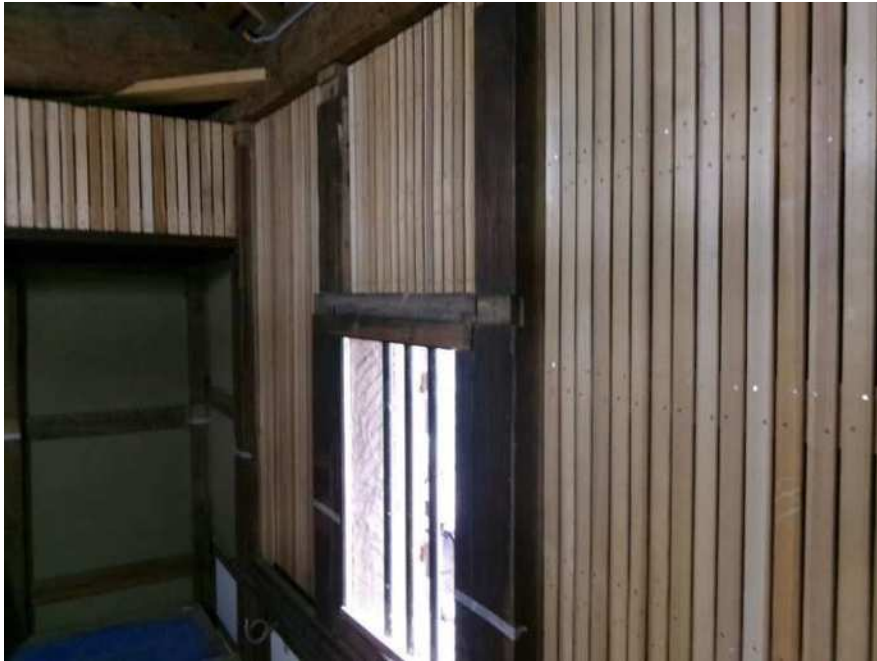
2階和室鼠漆喰壁木摺り下地
