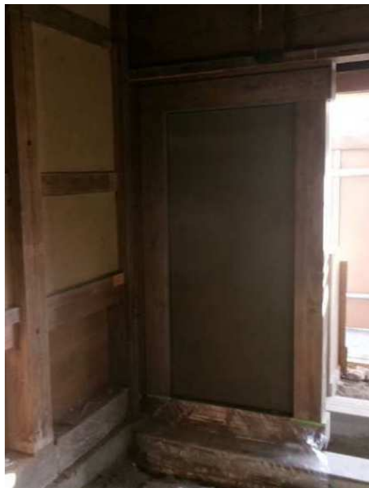
耐震補強壁の裏側に塗られた荒壁
