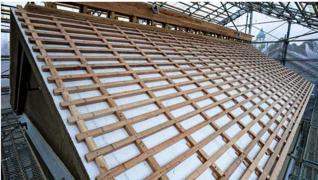
屋根土居塗漆喰仕上げの上に瓦棧設置・箱棟木下地完了(最上部)
