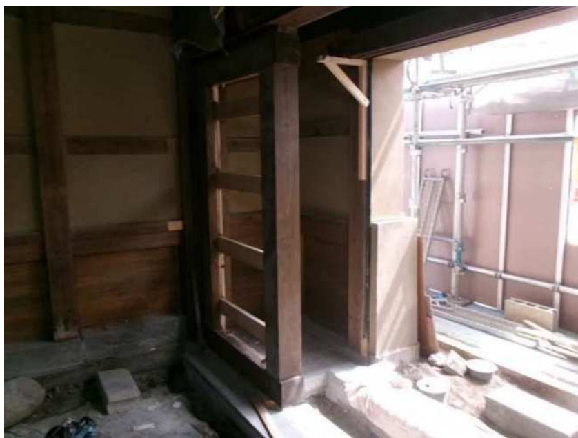
耐震補強壁木造軸組みフレーム建込み
