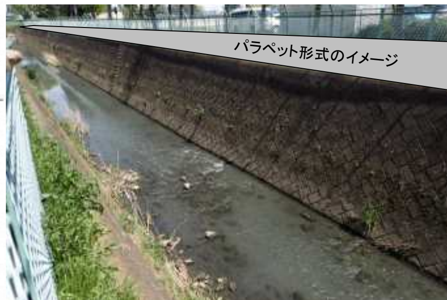
パラペット形式の護岸かさ上げイメージ図
