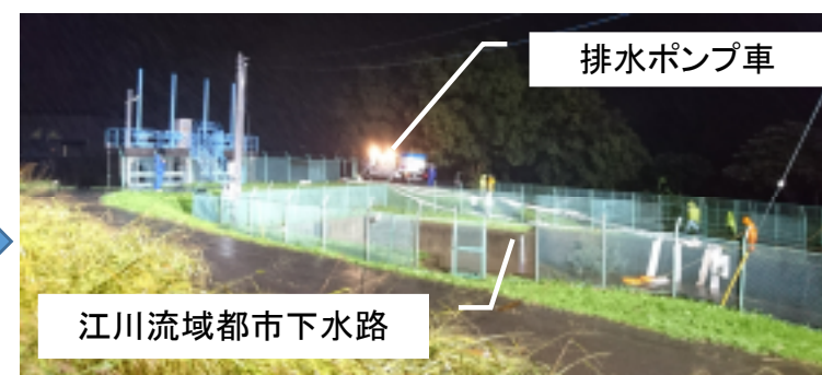
平成29年10月台風第22号 排水ポンプ車配備状況
