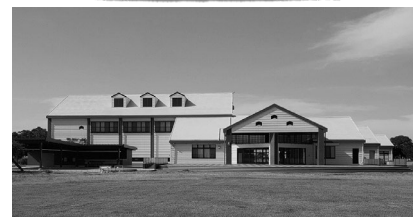
グリーンツーリズム拠点施設
