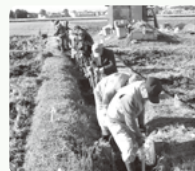
水路の泥上げ
