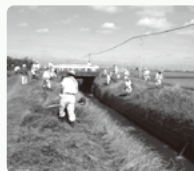
水路法面の草刈り
