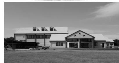
グリーンツーリズム拠点施設
