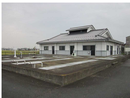
鴨田農業集落排水処理施設
