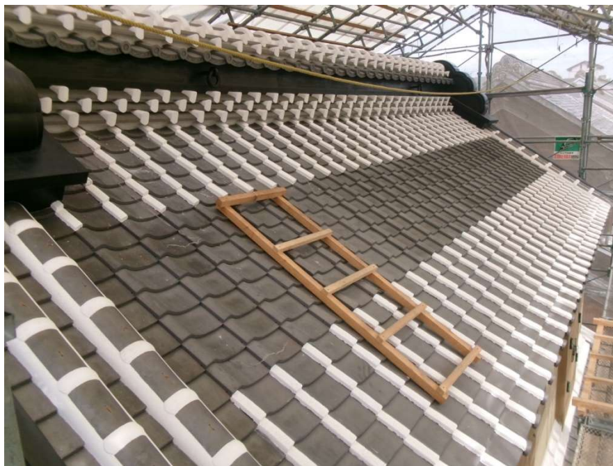
屋根棧瓦に施された棒漆喰(棧瓦の重ね目に塗られた白漆喰)
