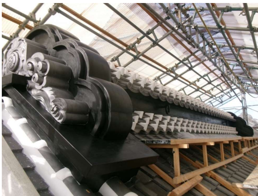
鬼台・影盛・箱棟の黒漆喰仕上げ(瓦の継ぎ目、重ね目は白漆喰仕上げ)
