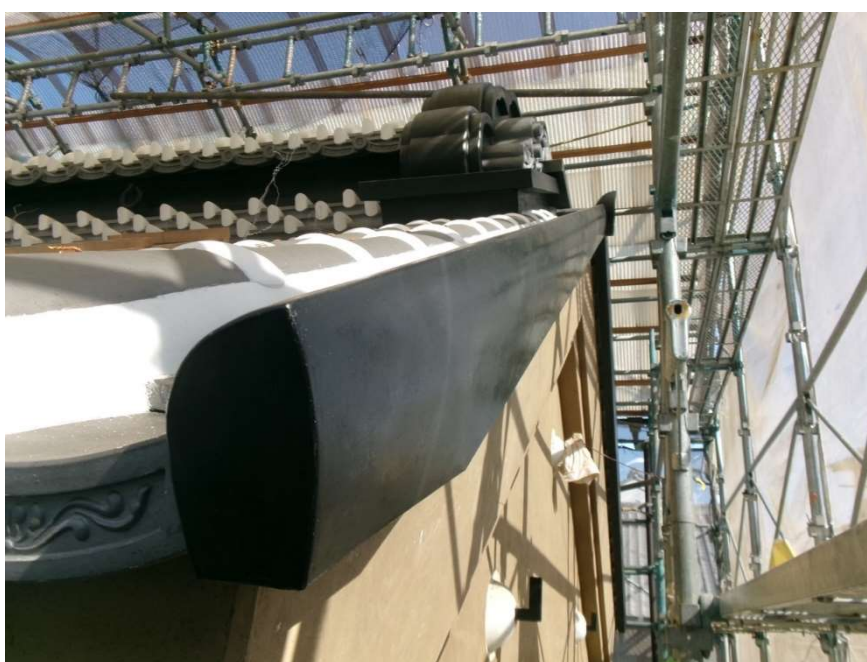
ケラバ(螻蛄羽)黒漆喰仕上げ
