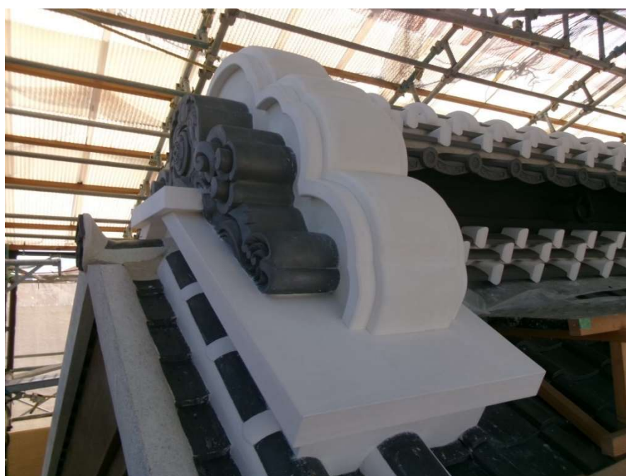
影盛上塗り(白漆喰)完了 箱棟大面部の仕上げ(黒漆喰)塗り
