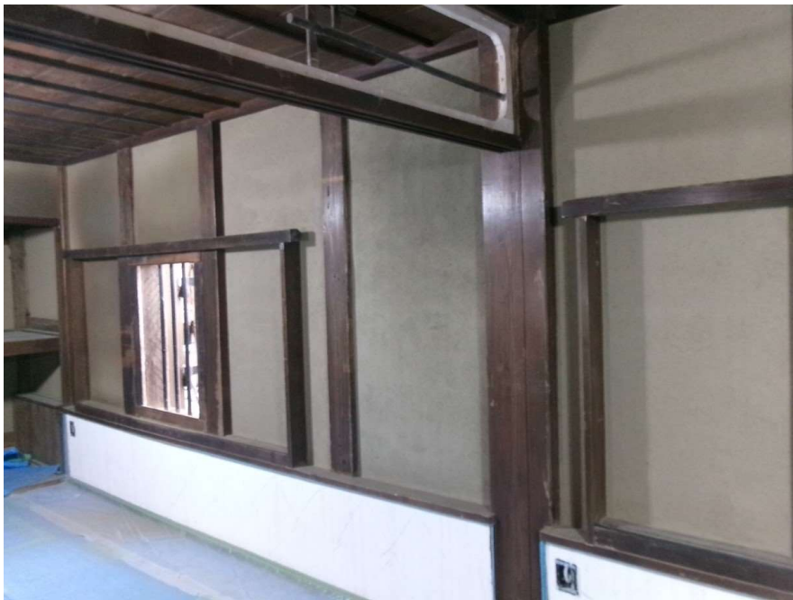
2階和室 鼠 ねずみ 漆喰壁中塗り
