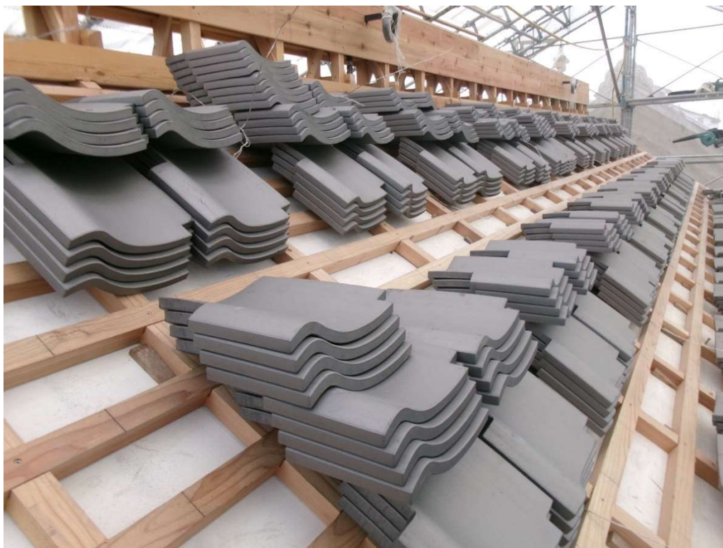
屋根瓦葺き準備工
