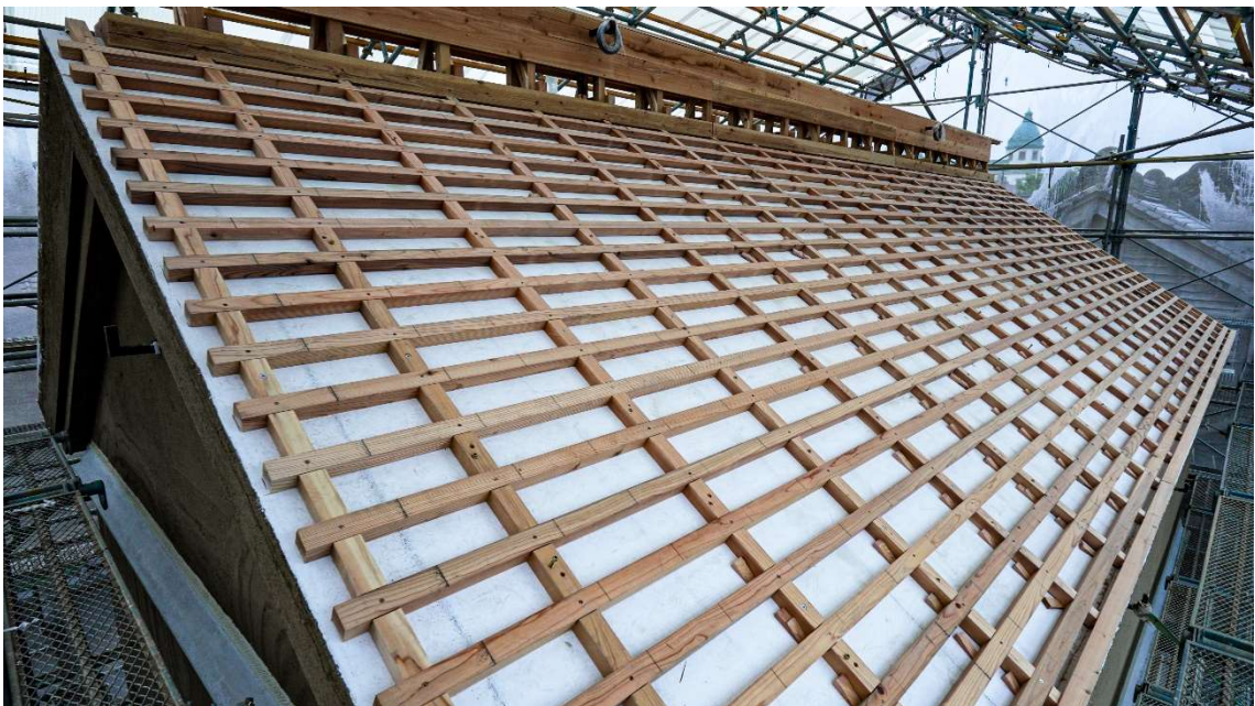
屋根土居塗漆喰仕上げの上に瓦棧設置・箱棟下地完了(最上部)
