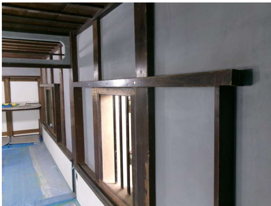
2階和室 ねずみ 鼠 漆喰壁完了
