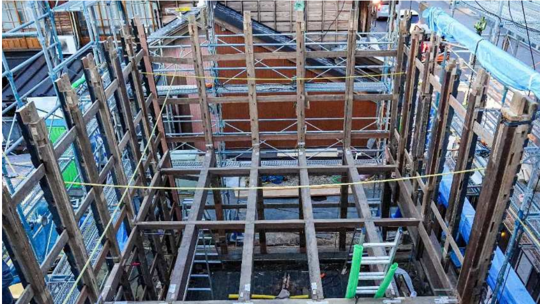
建方（柱、貫、床梁）
