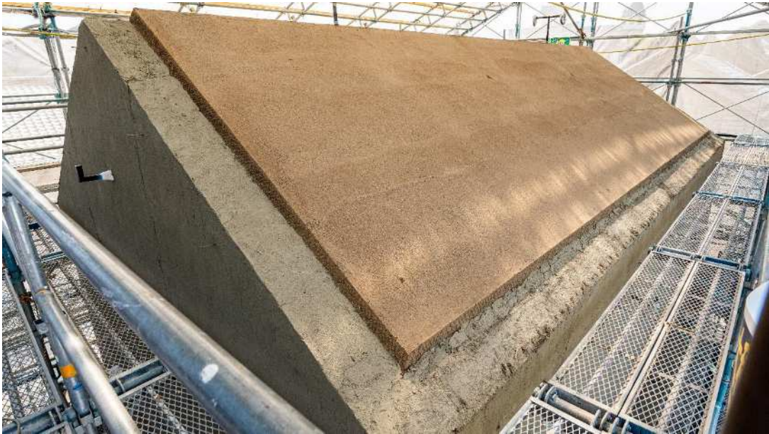
縦縄入れ後の乾燥養生（屋根）
