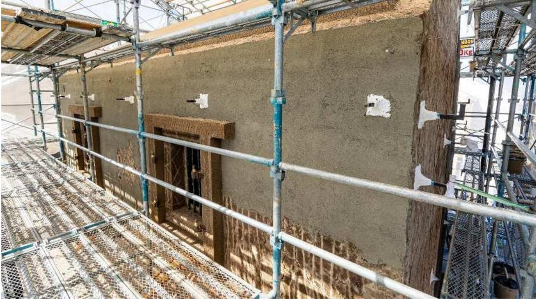
荒壁を平らにしていくため砂摺りの土を塗る
