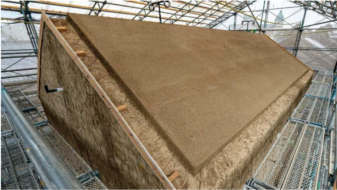
屋根土居塗り（追加塗り後）乾燥養生
