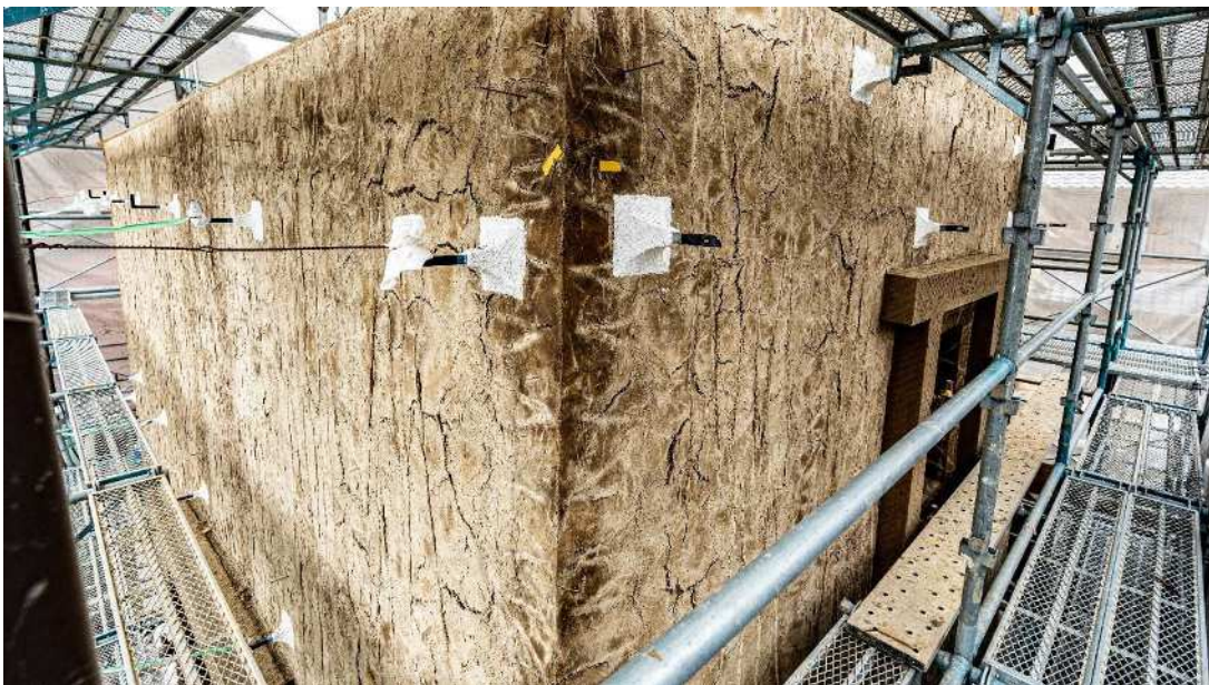
荒壁乾燥養生
