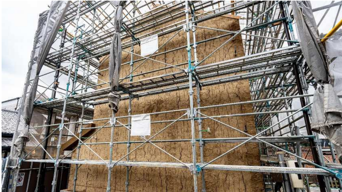
荒壁(表塗り)乾燥養生
