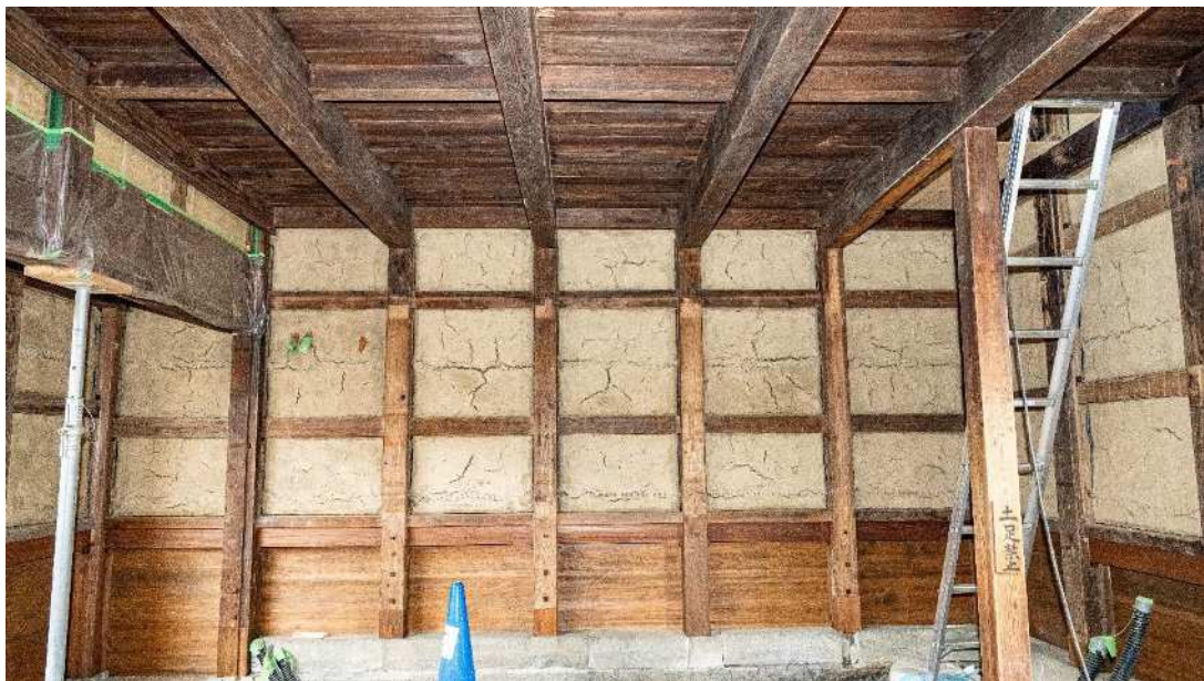
荒壁(裏返し塗り)乾燥養生
