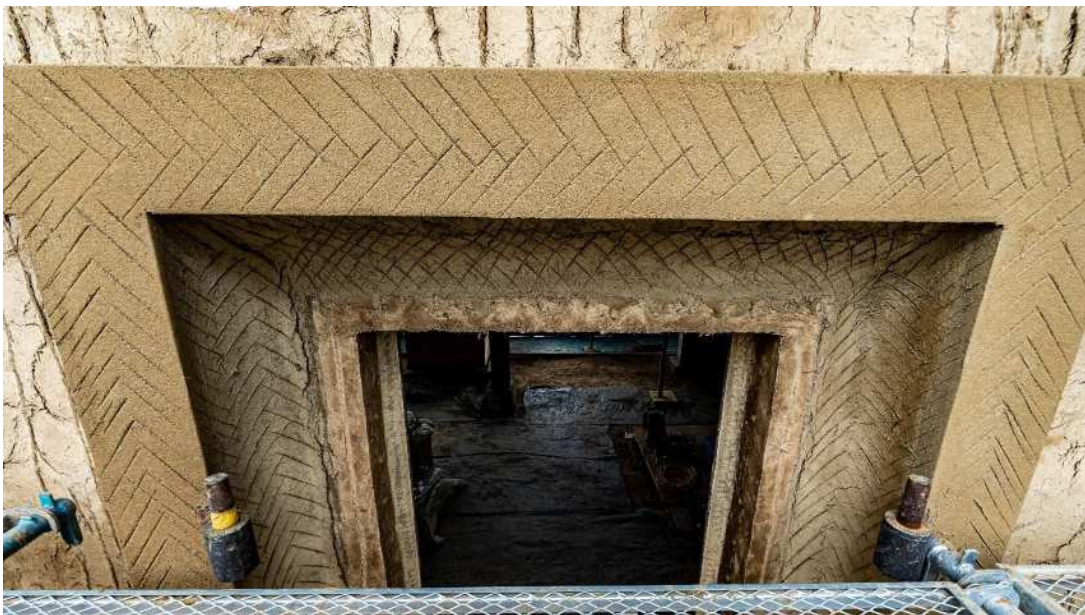
模様のようなヒガキを施された戸前(蔵の入口)周り乾燥養生
