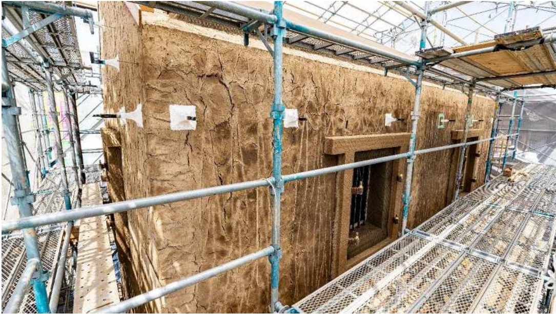
荒壁(表塗り)乾燥養生
