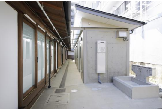
外観（西水廻り棟）
