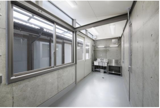
東水廻り棟 作業室
