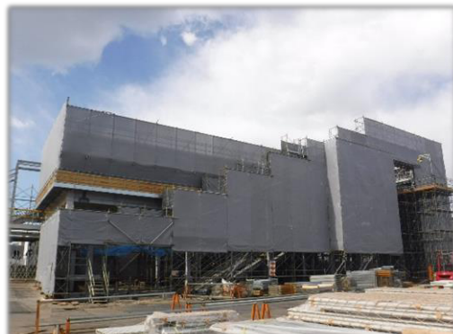
現在の東口工事の状況
