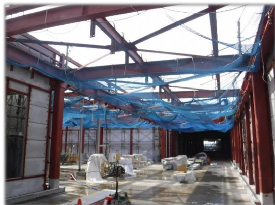
自由通路工事の状況
