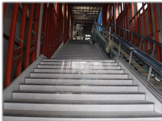
西口エスカレーター設置工事の状況
